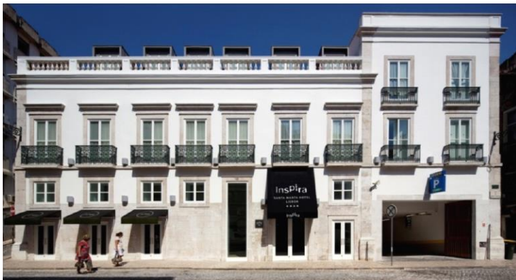
Fachada renovada/ New Façade
